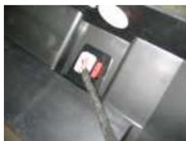
Pour fixer le caisson, il est nécessaire de poser des inserts filetés à riveter. (non fournis)
